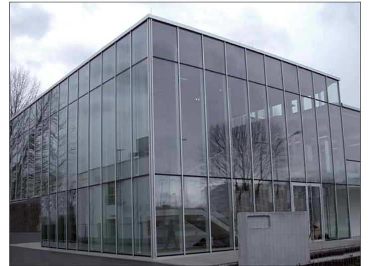
Kurz vor der Fertigstellung: Das neue Zentral-Europäische Zentrum der NSK Europe GmbH in Eschborn.
