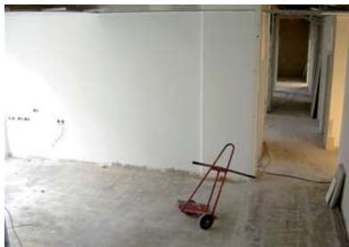
Ausbau: Der zukünftige Rezeptionsbereich.
