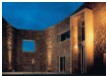
Das maßgeschneiderte zweite Firmengebäude für die Firmengruppe DT&SHOP mit der Bauherrin Frau Eva Maria Roer.
