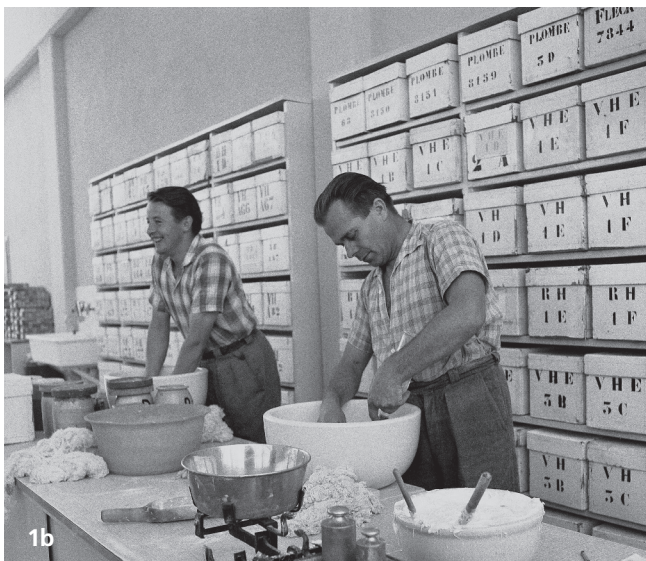
Abb. 1b: Arbeiter in den 1950er-Jahren beim Zusammenmischen verschiedener Rohstoffe zu einer Masse für die Kunstzahnproduktion.
