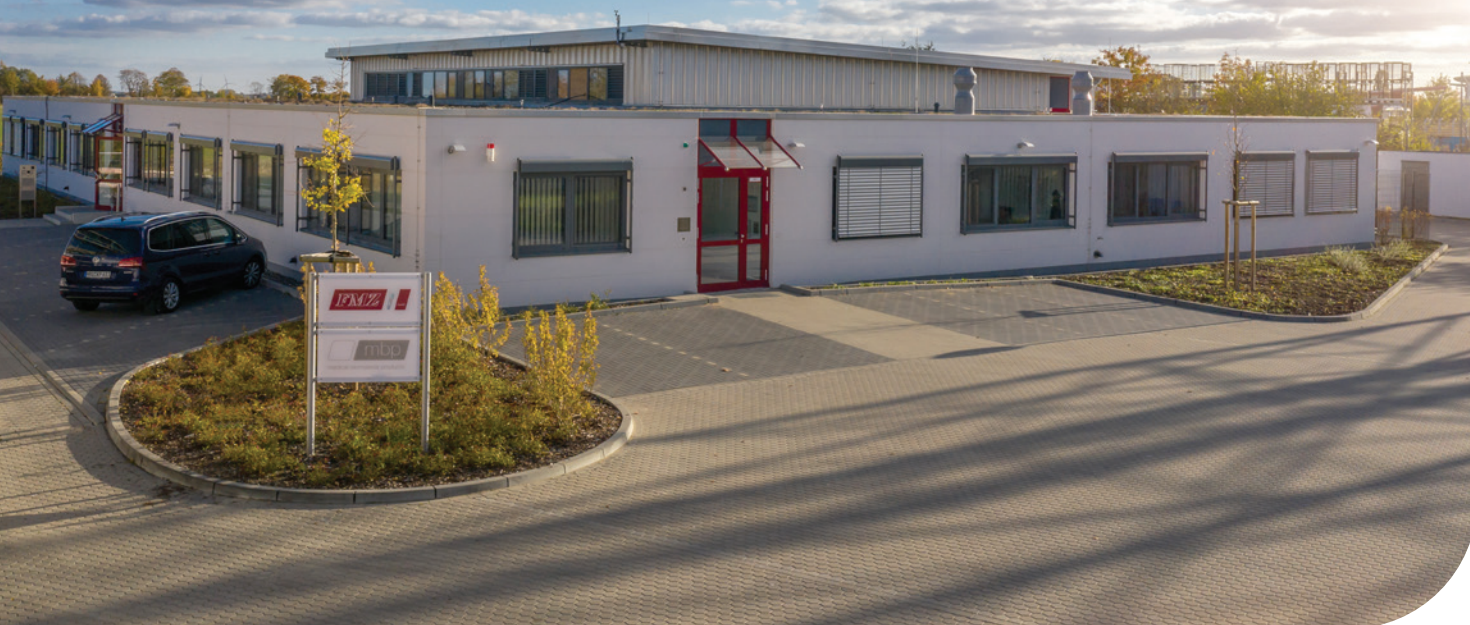
Abb. 4: Das Betriebsgebäude der FMZ GmbH in Rostock.
