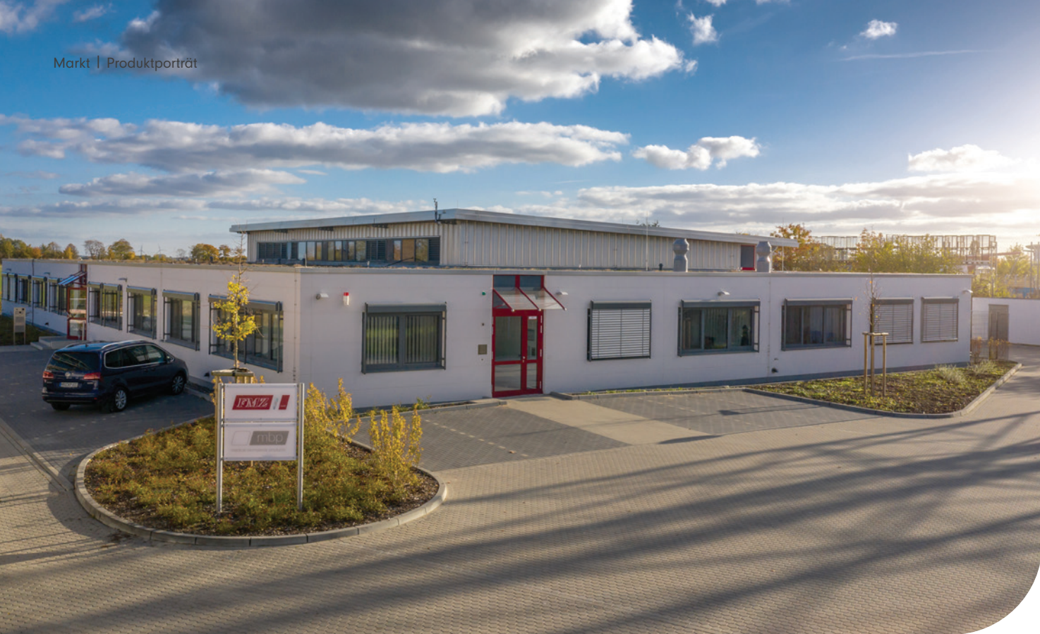
Abb. 4: Das Betriebsgebäude der FMZ GmbH in Rostock.
