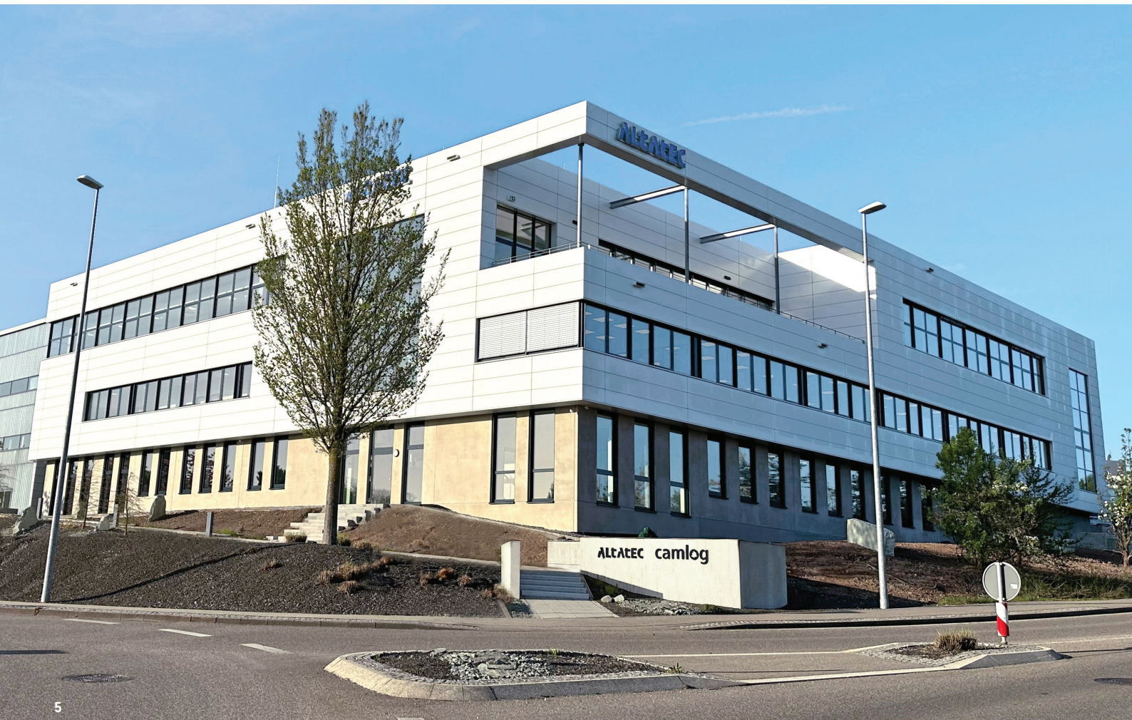
Abb. 5: Derzeit entsteht mit rund 6.500 Quadratmetern neuer Produktionsfläche der dritte Erweiterungsbau, die Zahl der Mitarbeitenden hat sich auf mehr als 600 erhöht.
