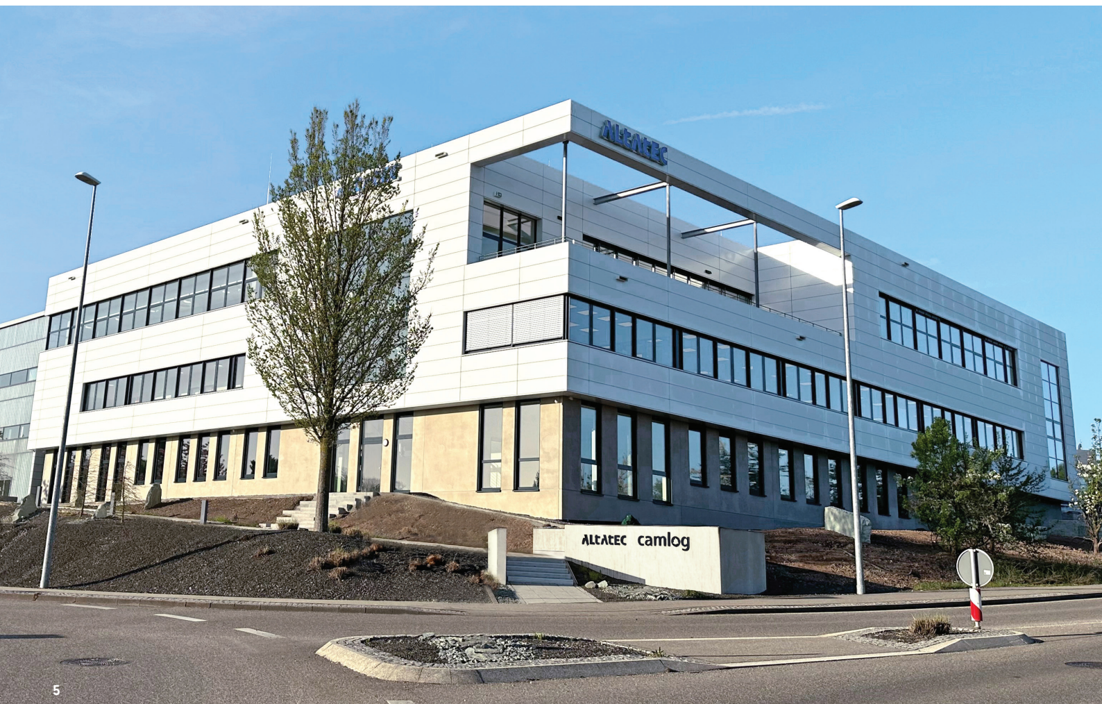
Abb. 5: Derzeit entsteht mit rund 6.500 Quadratmetern neuer Produktionsfläche der dritte Erweiterungsbau, die Zahl der Mitarbeitenden hat sich auf mehr als 600 erhöht.
