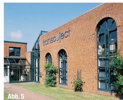
▲ Abb. 5: Das alte Gebäude der Transcoject in Neumünster.
