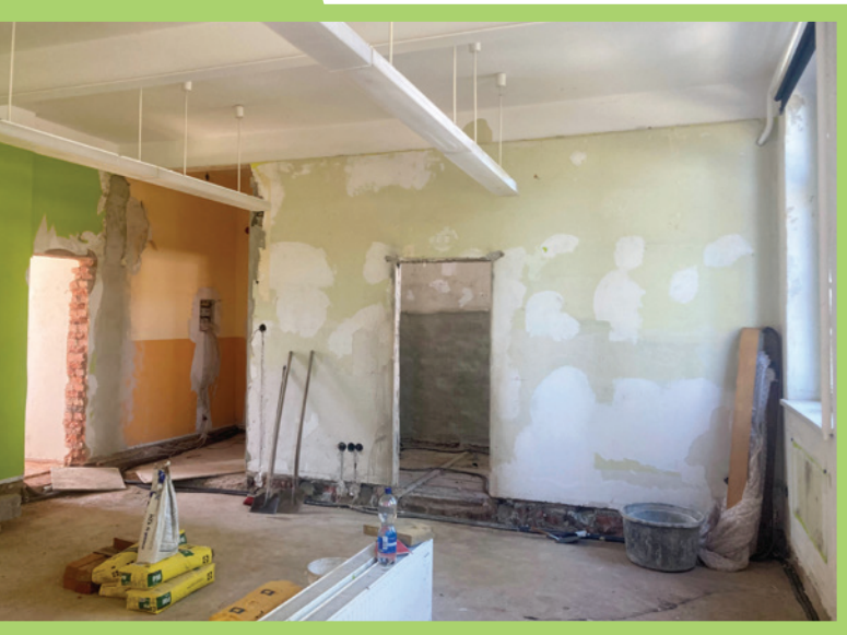
Derzeit ist der Umbau der ehemaligen Kita-Gruppenräume in vollem Gange.
