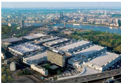
▲ Luftaufnahme der Koelnmesse, Eingang Nord, Messehochhaus, im Hintergrund das Kölnpanorama.
