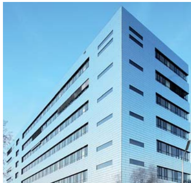
SICAT Fertigungszentrum, Schwertbergerstraße 14, Bonn
