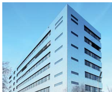
SICAT Fertigungszentrum, Schwertbergerstraße 14, Bonn
