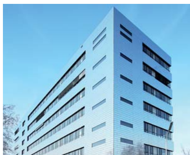
SICAT Fertigungszentrum, Schwertbergerstraße 14, Bonn
