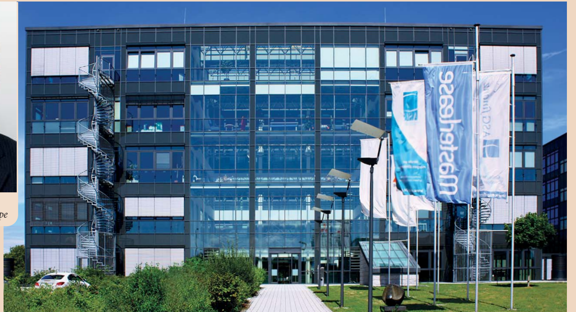
Die neue europäische Firmenzentrale von Kuraray in Frankfurt am Main.
