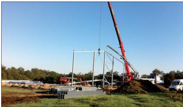
Impressionen der Bauphase.
