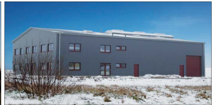
Der Neubau umfasst einen 2-stöckigen Verwaltungstrakt sowie eine großzügige Lagerhalle mit Werkstatt.
