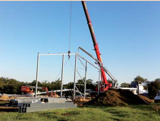
Impressionen der Bauphase.
