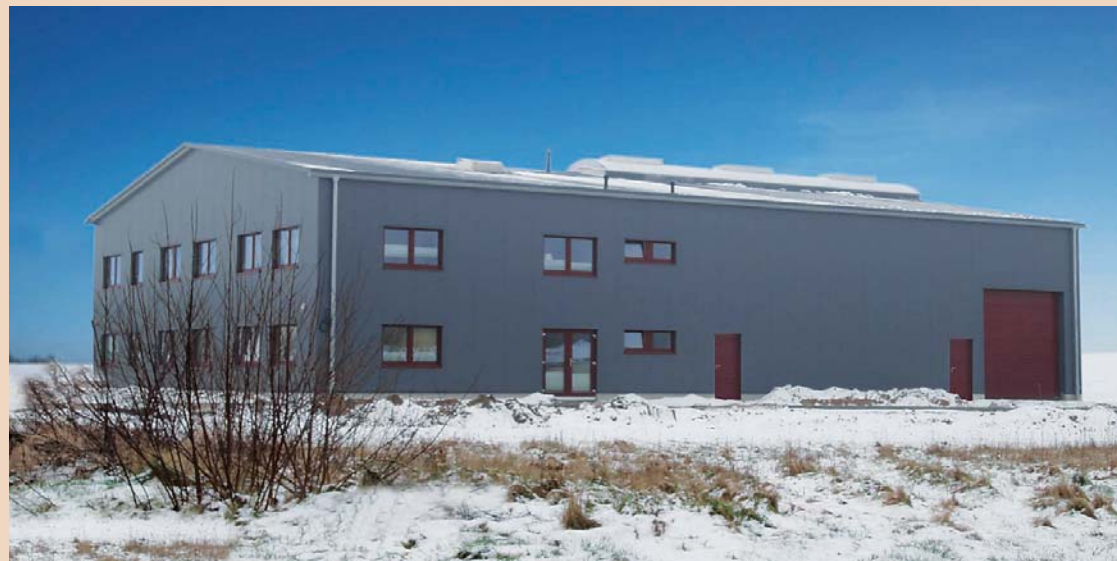
Der Neubau umfasst einen zweistöckigen Verwaltungstrakt sowie eine großzügige Lagerhalle mit Werkstatt.
