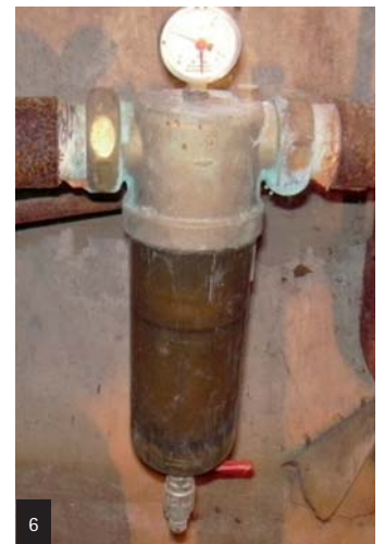
Abb. 4: Dosierstation Synchronodos plus. – Abb. 5: Sicherungseinrichtung Flow-Neo. – Abb. 6: Verschmutzte Filter sind eine Ursache der Wasserkontamination.
