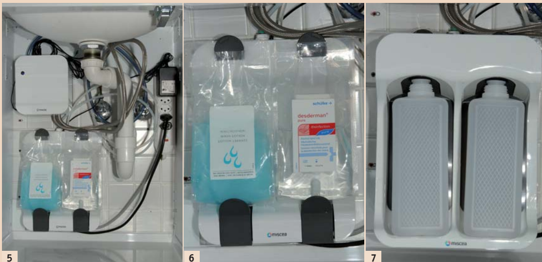
Abb. 5: Montageelemente im Unterbau-Schränkelement: separates Wasser- und Dispensionsmedien-Modul. – Abb. 6: Modulbox für Seife und Desinfektionslösung mit Einweg-Beutelsystem. – Abb. 7: Modulbox für Seife und Desinfektionslösung mit Mehrweg-Flaschensystem.
