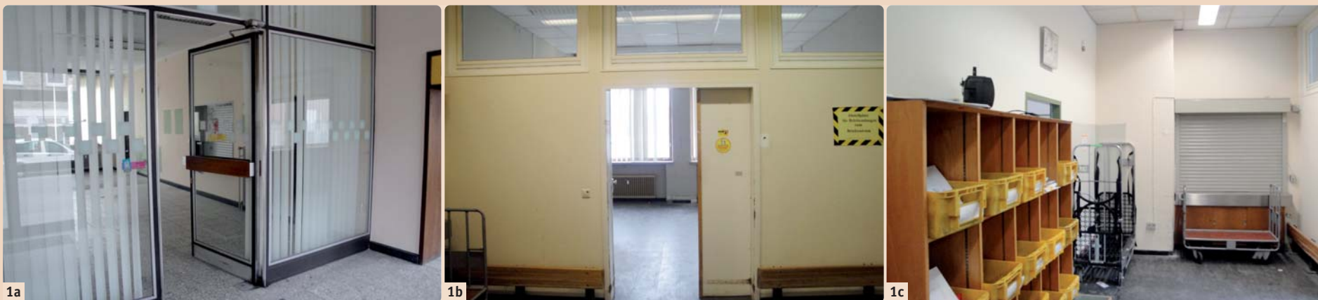
Abb. 1a–c: Vor dem Umbau war die Praxis eine ehemalige Postfiliale.
