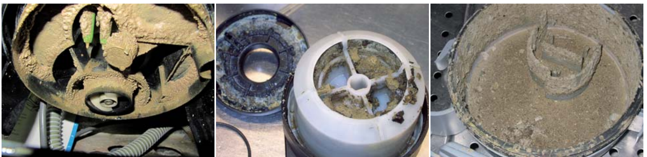
Ein Blick in das Innere einer Sauganlage, bei der keine Sauganlagendesinfektion zum Einsatz kam.
