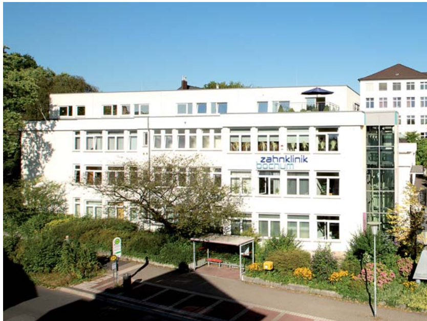
▲ Die Zahnklinik Bochum besitzt 14 Behandlungseinheiten. Durch die professionelle Zusammenarbeit von Gesundheitsamt, Spezialisten des Depots, Installateuren und Profis aus dem Bereich der Wasserhygiene konnte der Weg für die Integration einer systematischen Wasserhygiene in bestehende Klinikstrukturen geebnet werden.
