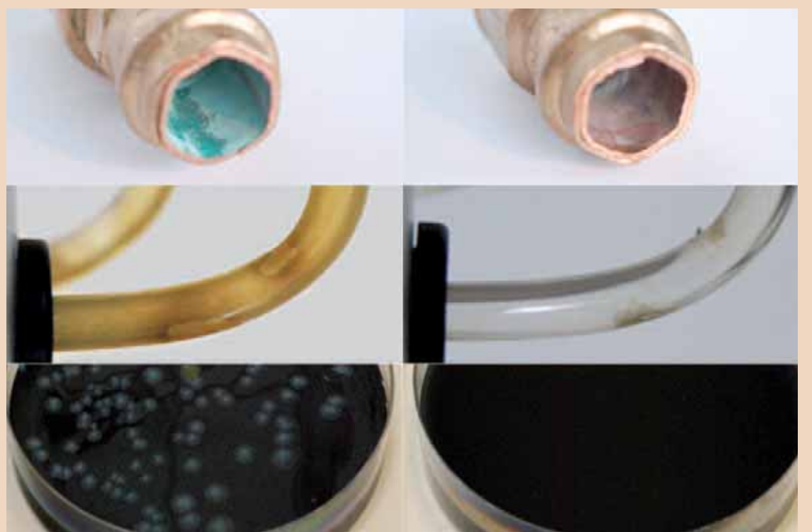
Biofilm in Hausinstallationen – vor Einsatz von SAFEWATER und nachher.
