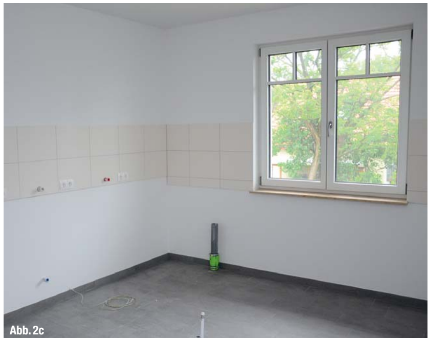
▲ Abb. 2a–c: Entstanden ist eine Laborfläche von 130 Quadratmetern, die durch klare Linien und großzügige Raumaufteilung besteht.
