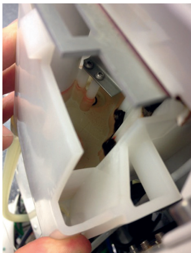
Abb. 1: Freie Fallstrecke gemäß DIN EN 1717 in Dentaleinheit (Weißer Behälter mit schwarzem Pilzbewuchs).
