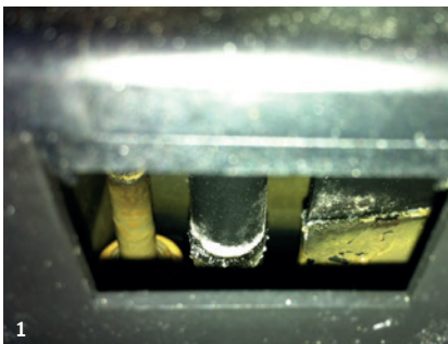
Abb. 1: Biofilm in einer freien Fallstrecke gem. DIN EN 1717 aus Plastik. – Abb. 2: Biofilm im Desinfektionsmittelkonzentratschlauch einer Dentaleinheit. – Abb. 3: Mineralische Ablagerung in der Verteilung einer Trinkwasserinstallation. – Abb. 4: Korrosion einer verzinkten Stahlleitung.
