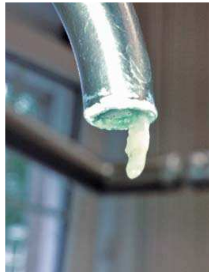
Biofilme in Trinkwasserinstallation und in dentaler Behandlungseinheit
