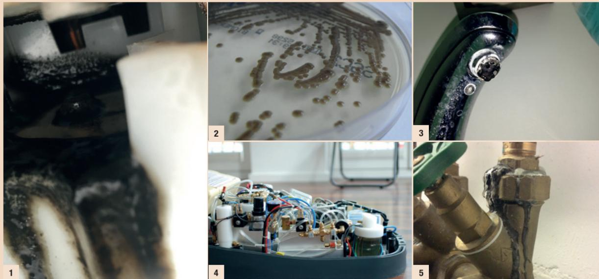
Abb. 1: *Exophiala*-Befall in freier Fallstrecke gem. DIN EN 1717. - Abb. 2: *Exophiala*-Kultur in Petrischale. - Abb. 3: *Exophiala*-Befall von Strahlregler an Armatur. - Abb. 4: Komplexes Schlauchsystem aus Kunststoff einer Behandlungseinheit. - Abb. 5: *Exophiala*-Befall einer Trinkwasserinstallation in einer Zahnarztpraxis. - Abb. 6: BLUE SAFETY SAFE BOTTLE System.
