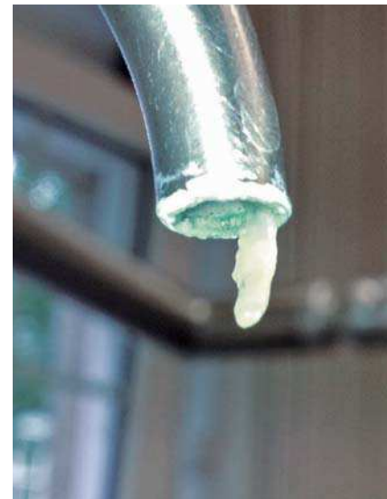
Biofilme in Trinkwasserinstallation und in dentaler Behandlungseinheit
