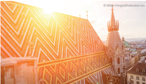
▲ Rund 230.000 Dachziegel, die in einem Zickzack-Muster arrangiert sind, bedecken das Dach des Stephansdoms.
