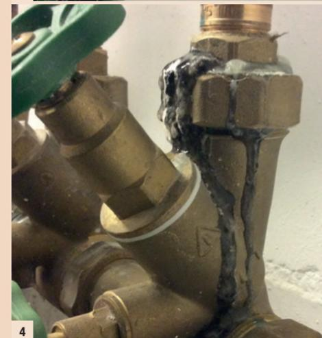
Abb. 3: Exophiala-Befall von Strahlregler an Armatur. - Abb. 4: Exophiala-Befall einer Trinkwasserinstallation in einer Zahnarztpraxis.
