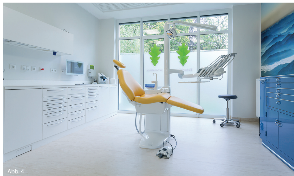
Abb. 4: In den Behandlungszimmern der Klinik sind Compact i-Behandlungstühle von Planmeca installiert.
