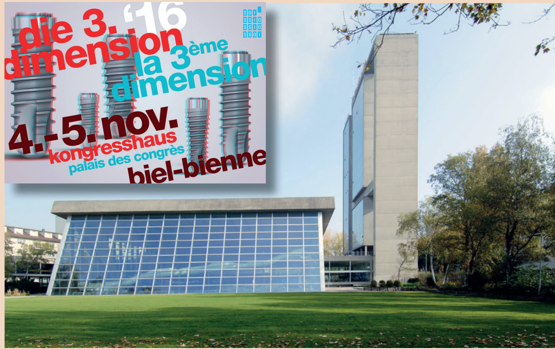
Das Kongresshaus in Biel ist Veranstaltungsort des Jahreskongresses der SGI. (© Stadt Biel)
