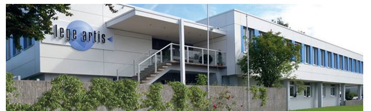
Abb. 1: Das lege artis-Firmengebäude in Dettenhausen.
