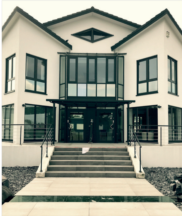
Der frisch sanierte Hauptsitz in Walsrode.
