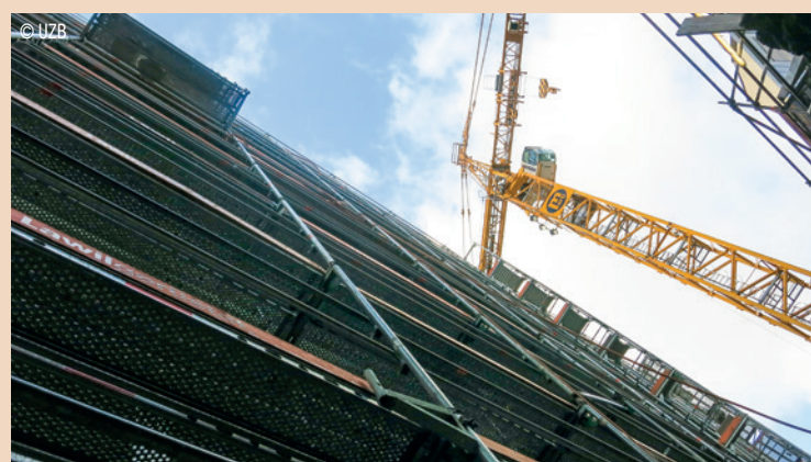
Der Neubau der UZB kommt termingerecht voran.
