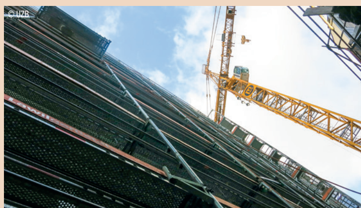
Der Neubau der UZB kommt termingerecht voran.
