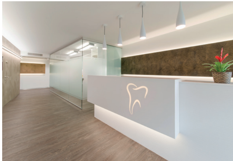
Links: Empfangsfront mit Strukturplatte MDF weiss lackiert und Abdeckung in Corian® Design Glacier White 12 mm mit eingefrästem Logo. Rechts: Empfang vor dem Umbau.
