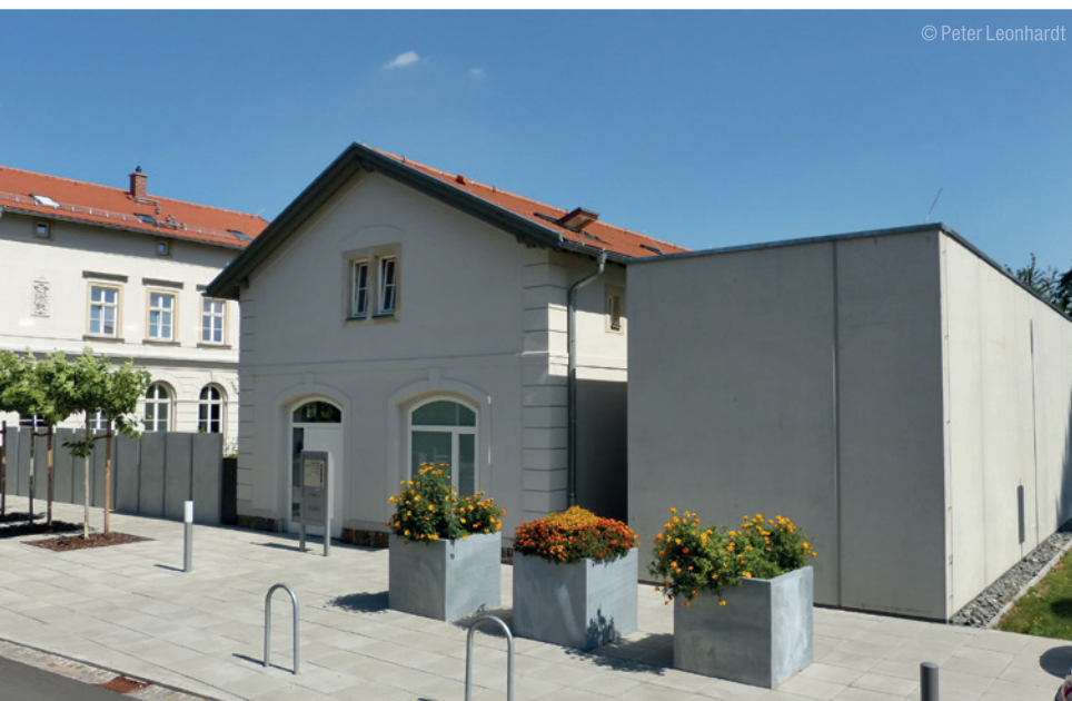
Abb. links: Neu neben alt – Der hochmoderne Flachdachkubus bildet einen spannenden Kontrast zum rekonstruierten Nebengebäude.
