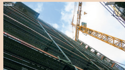
Der Neubau der UZB kommt termingerecht voran.
