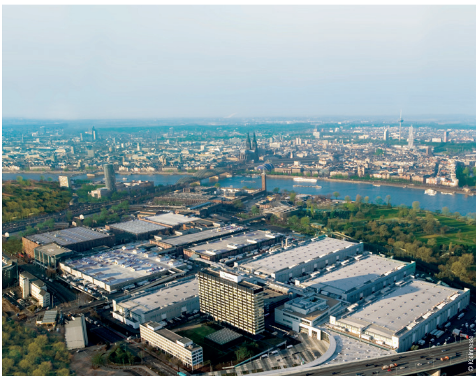
• Luftaufnahmen der Koelnmesse, Eingang Nord, Messehochhaus, im Hintergrund das Kölnpanorama.
