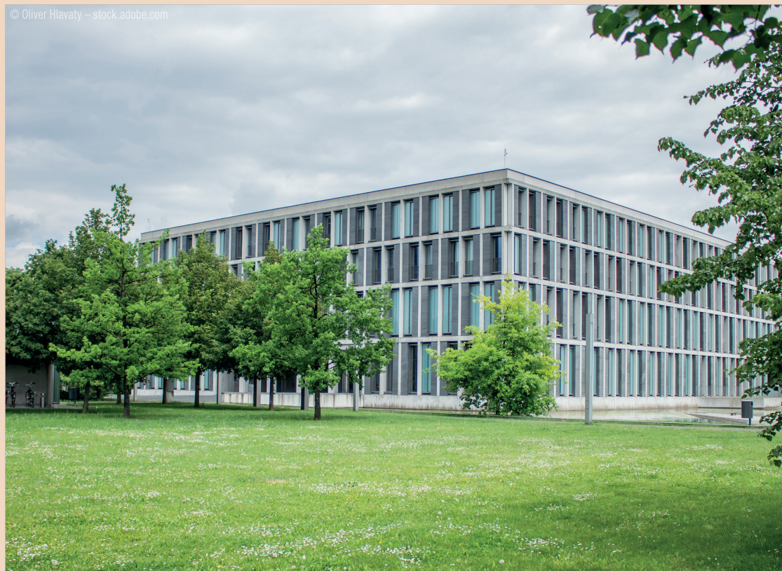
Bundesarbeitsgericht in Erfurt.
