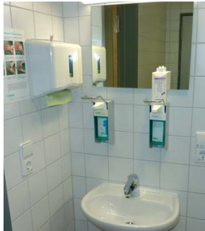
Abb. 5: Am Handwaschbecken sind ein Seifen-, Desinfektionsmittel- und möglichst auch Schutzcremespender mit Ellbogenbetätigung anzubringen. – Abb. 6: Automatische Dosiereinrichtung für Flächendesinfektion.
