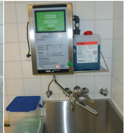
Abb. 5: Am Handwaschbecken sind ein Seifen-, Desinfektionsmittel- und möglichst auch Schutzcremespender mit Ellbogenbetätigung anzubringen. – Abb. 6: Automatische Dosiereinrichtung für Flächendesinfektion.
