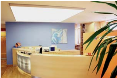
Abb. 3: Lichtfeld: ergonomisches Licht und Akzentlicht in einem Element.
