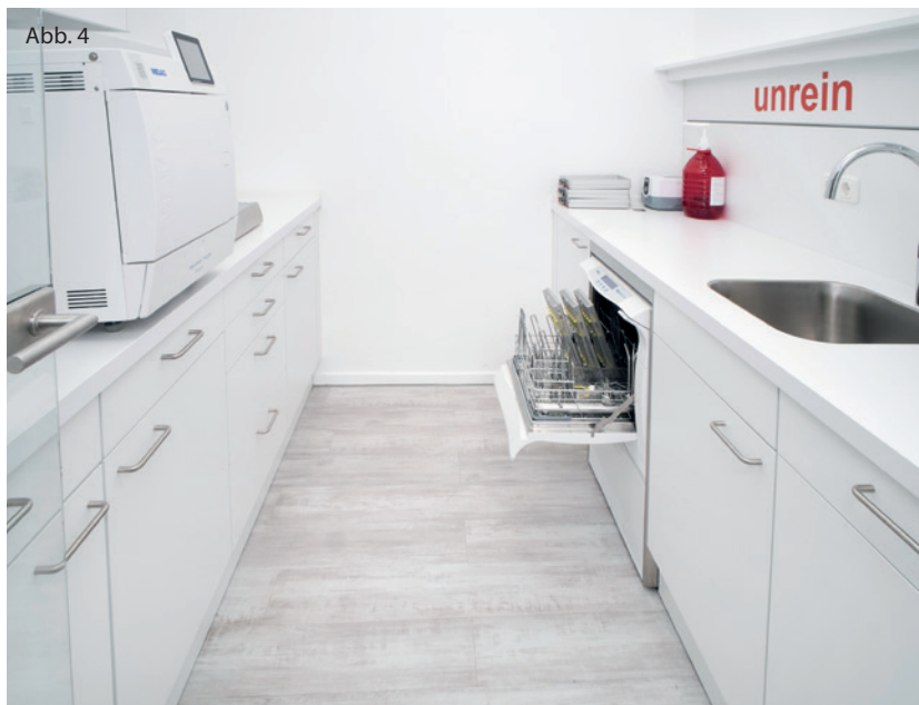
Abb. 4: Ein Blick in den Aufbereitungsraum mit Vacuklav 40 B+ Evolution und MELAtherm 10.
