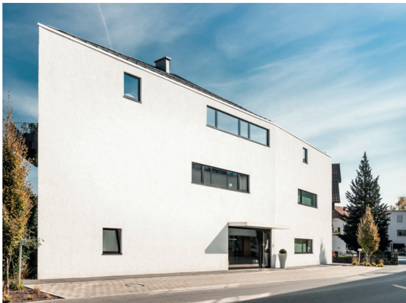
Abbildung oben: Straßenseitig fällt die urbane Fassade des Wohn- und Geschäftshauses auf, das Kundenparkplätze direkt vor der Ordination bietet.
