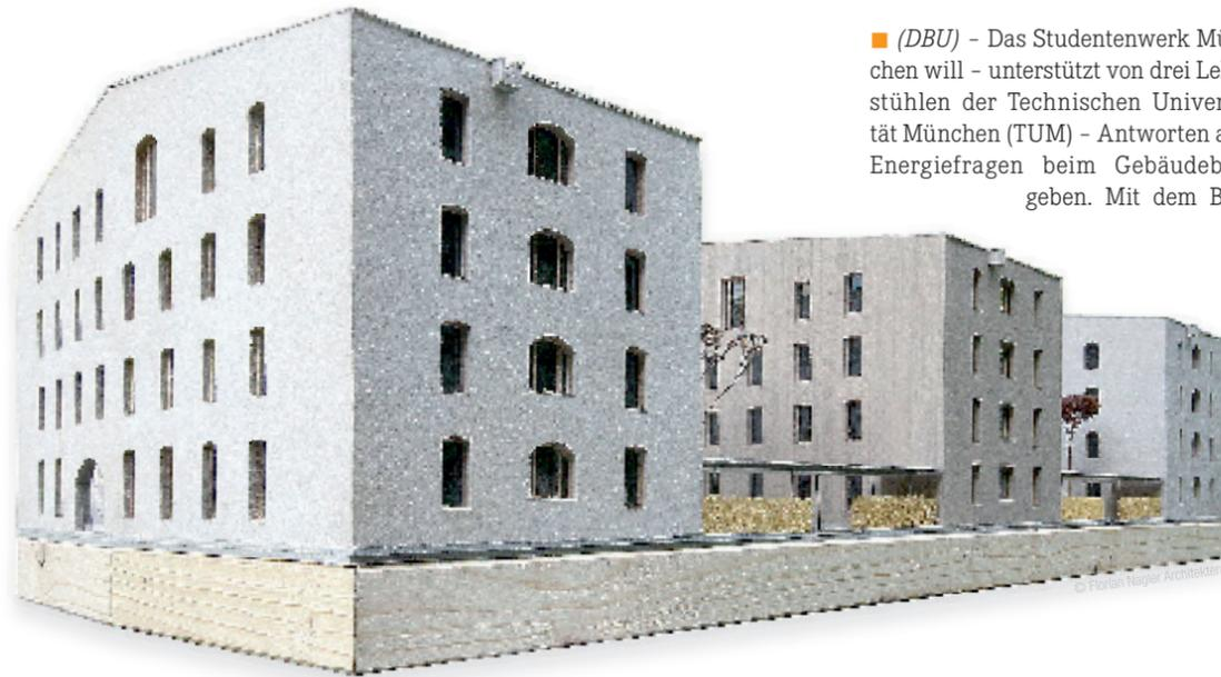
dreier Studentenwohnhäuser in gleicher Geometrie und Größe, die aus unterschiedlichen Materialien errichtet werden, soll auf dem Campus in Garching ein Null-Energie-Standard erreicht werden: ein Haus aus Leichtbeton ohne Stahl, eines aus dem nachwachsenden Baustoff Massivholz und eines aus hochwärmedämmendem Mauerwerk. Die Deutsche Bundesstiftung Umwelt (DBU) unterstützt das Vorhaben fachlich und finanziell.
