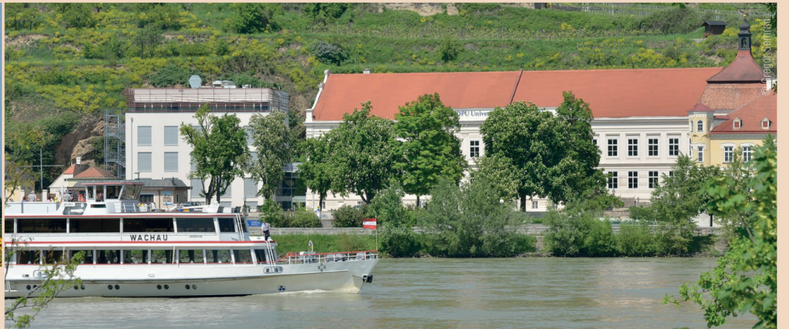
Das Bild zeigt ein Lehrgebäude der DPU mit angrenzendem Zahnambulatorium Krems. In der Folge schließen sich Gebäude mit Räumlichkeiten für Lehre, Forschung, Praktika und Verwaltung (insgesamt rund 9.000 Quadratmeter Nutzfläche) an, ausgestattet mit Equipment State of the Art und Kunst, die eine Aussage zum Zeitgeschehen bietet.
