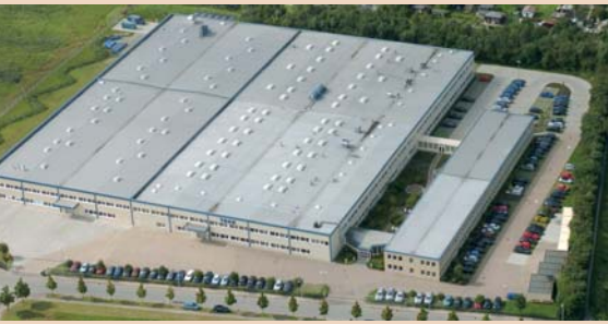
Luftansicht der VOCO Firmenzentrale in Cuxhaven.
