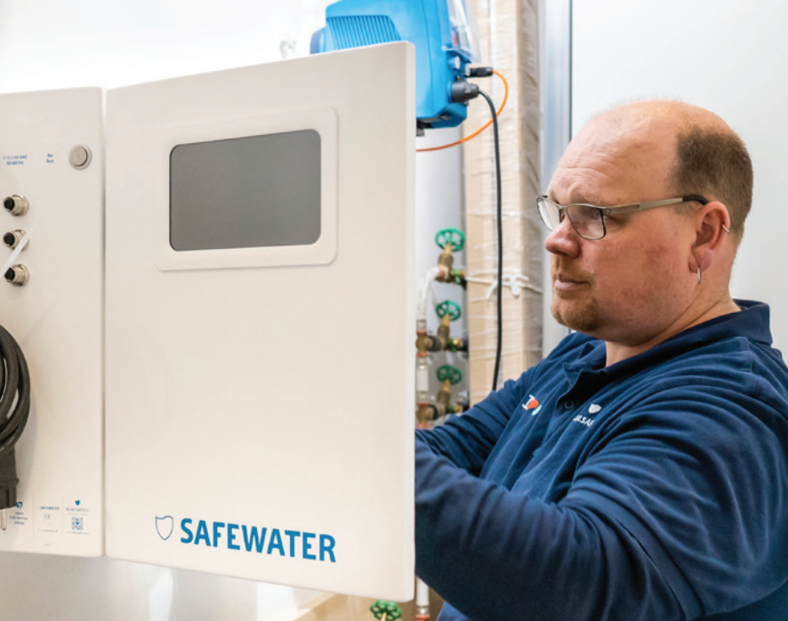
Thomas Keute installierte SAFEWATER bei laufendem Praxisbetrieb.
