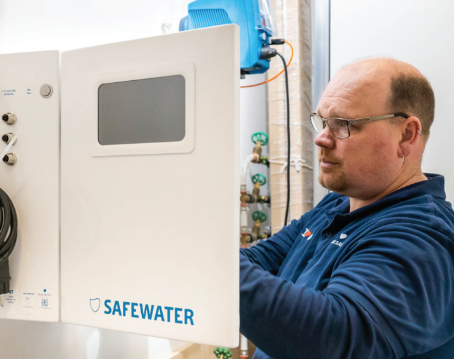
Thomas Keute installierte SAFEWATER bei laufendem Praxisbetrieb.
